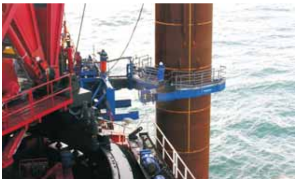
图1 单基桩打桩，桩长50或54m，水深19-24m。来源：Q7海上风场
