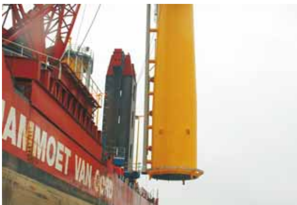
图2 单基桩上的转接段定位，高出海平面15m
